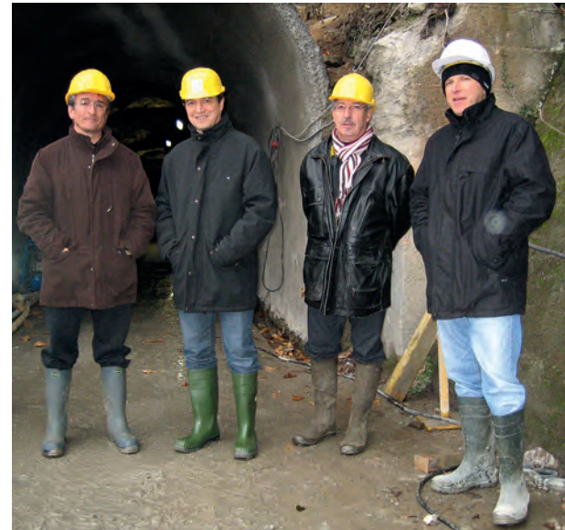
Les élus en visite sur le chantier EDF : Rémy Fortanier, Pascal Bugis, Francis Ribelles et Gérard Cauquil.
